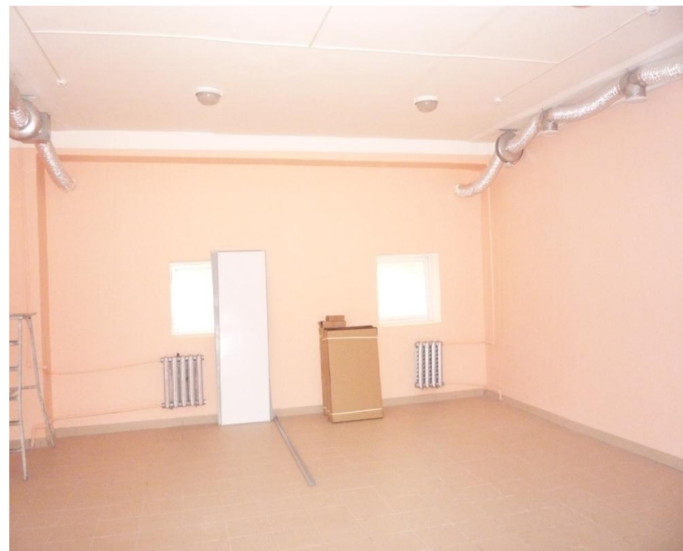
ремонт в архивохранилище № 2 (комн.142)
