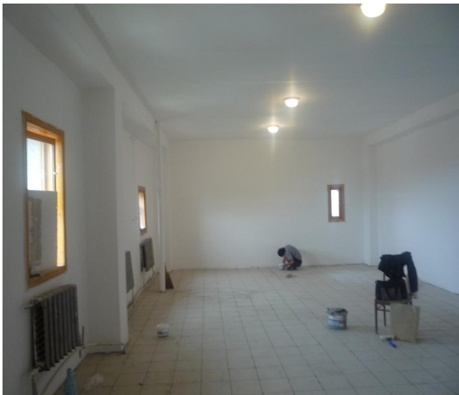
ремонт в архивохранилище №1 (комн.209)
