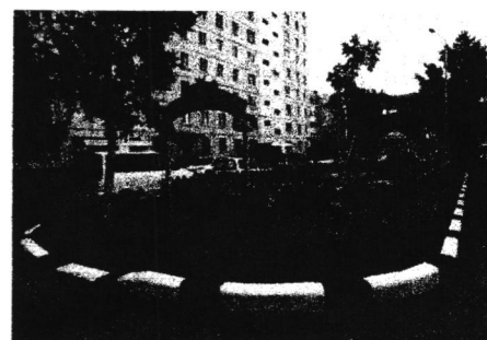
Ремонт дворов и внутриквартальных проездов
